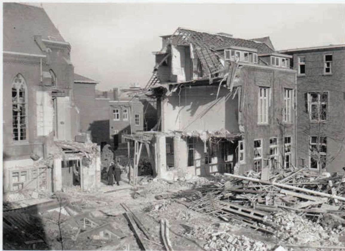
Schade aan het Binnen- zieken- huis.
